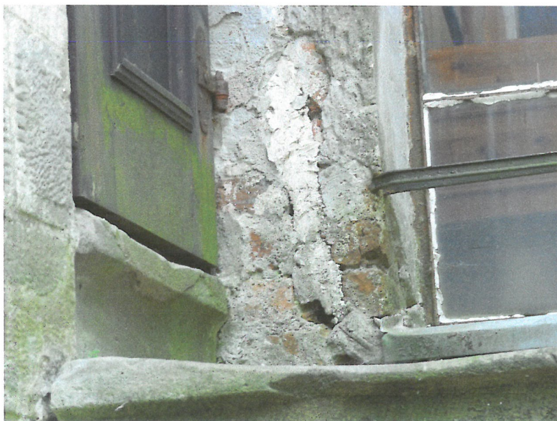
fot.8, 9,10 Wyraźne zawilgocenia ścian wewnątrz kościoła od elewacji północnej.
