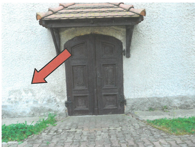
fot.12,13 Fragment elewacji północnej, widoczne zawilgocenia, muru, oraz opaskę betonową.
