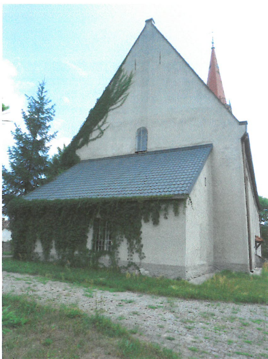
Fot.4 Widok na elewację tylną zachodnią
