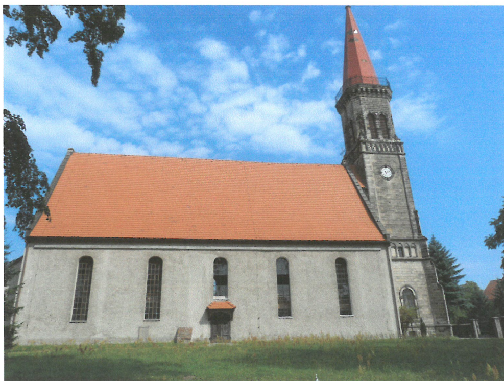
fot.3 Widok na elewację boczną południową
