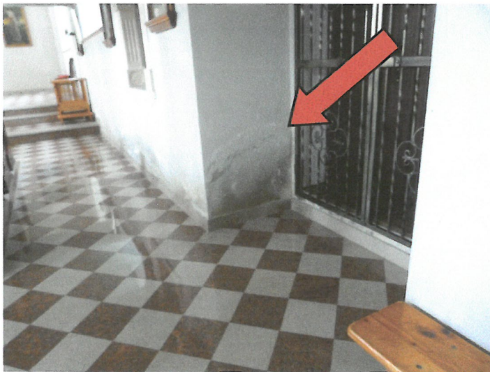
fot.8, 9,10 Wyraźne zawilgocenia ścian wewnątrz kościoła od elewacji północnej.
