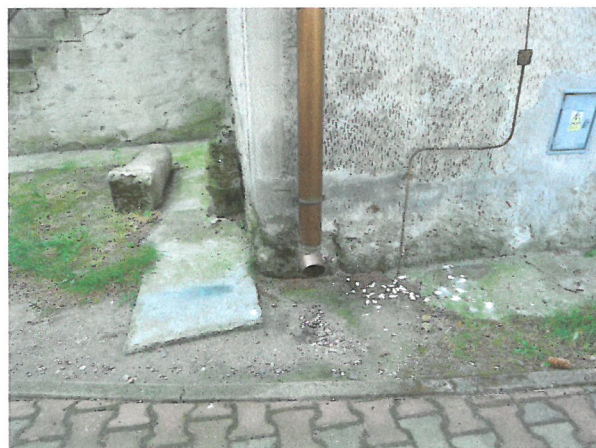
fot.12,13 Fragment elewacji północnej, widoczne zawilgocenia, muru, oraz opaskę betonową.
