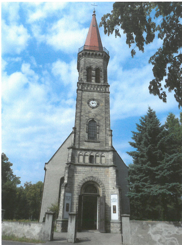
fot.2 Widok na elewację frontową wschodnią
