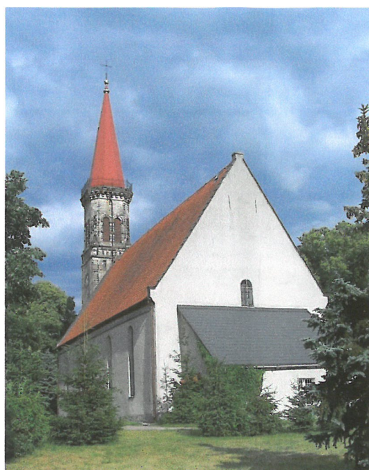
Fot.5 Widok na elewację północną i zachodnią
